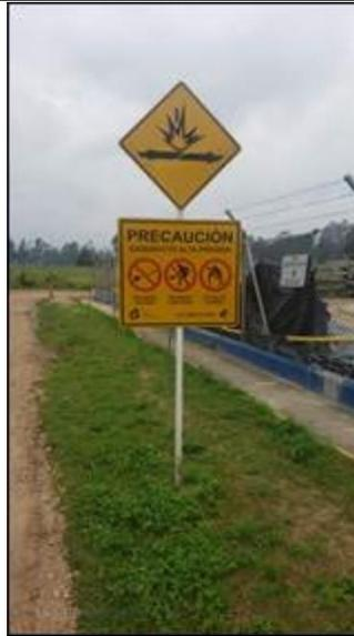
Ilustración 8. Señal terrestre instalada para cruce en el derecho de vía
